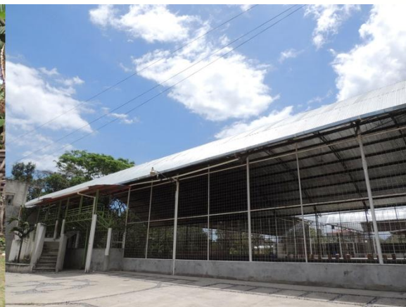
Figura 31. Comercio de estructura metálica Fuente: Diego Zambrano, 2017
