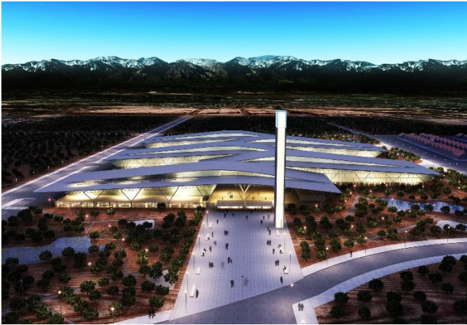
Figura 15. Vista aérea nocturna desde ingreso principal
