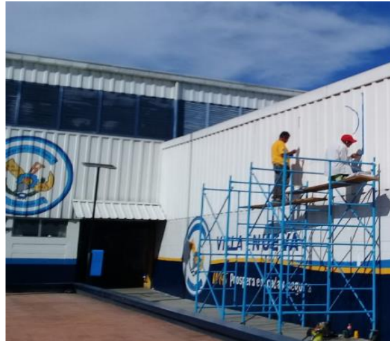
Imagen No. 11 Análisis estructural Mercado Villa Nueva
