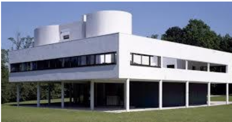
Imagen No. 6 Movimiento moderno
