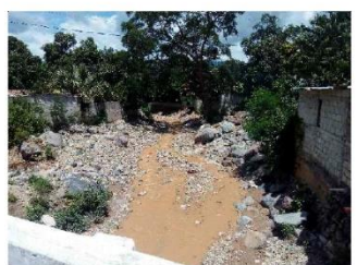
Quebrada "Tacó" 01 En esta quebrada se encauzan varios drenajes de la ciudad fuente: propia
