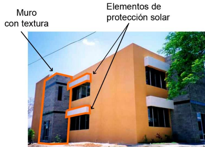
Edificio educativo C-1 fuente: www.constructoralyon.com
