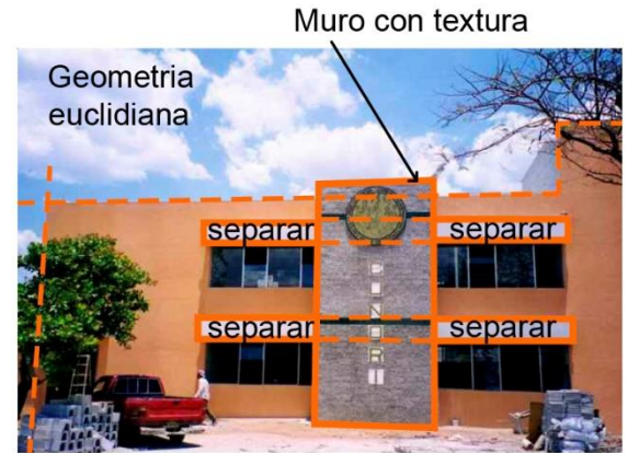
Edificio educativo C-1 fuente: www.constructoralyon.com
