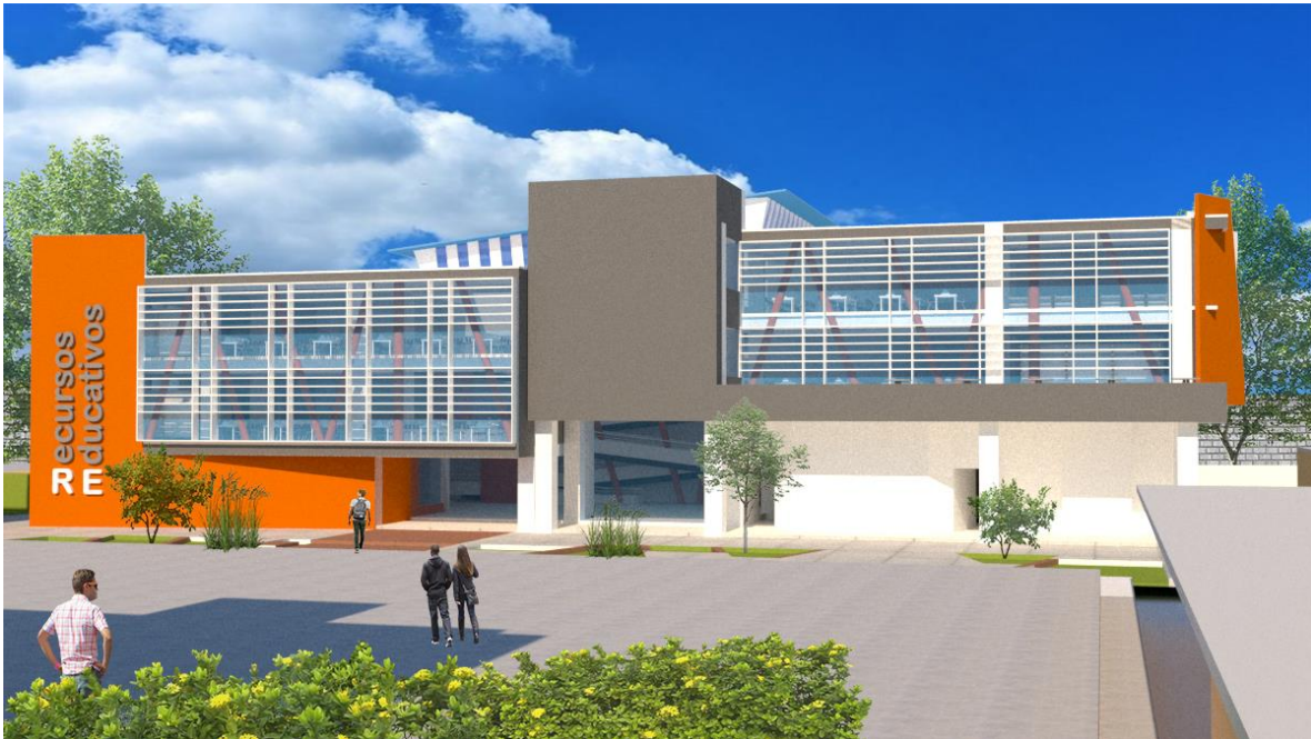
Plaza de ingreso al edificio
