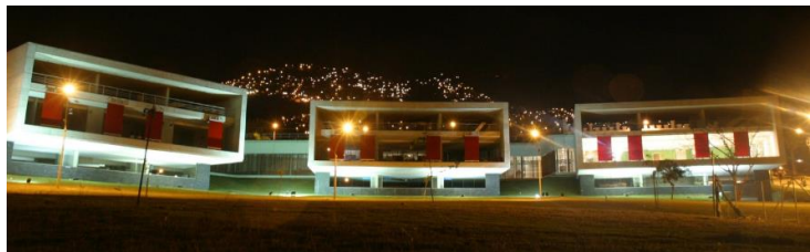
Figura 50, Fachada de Biblioteca León de Greiff, (Colombia, 2008), de Sergio Gómez.
