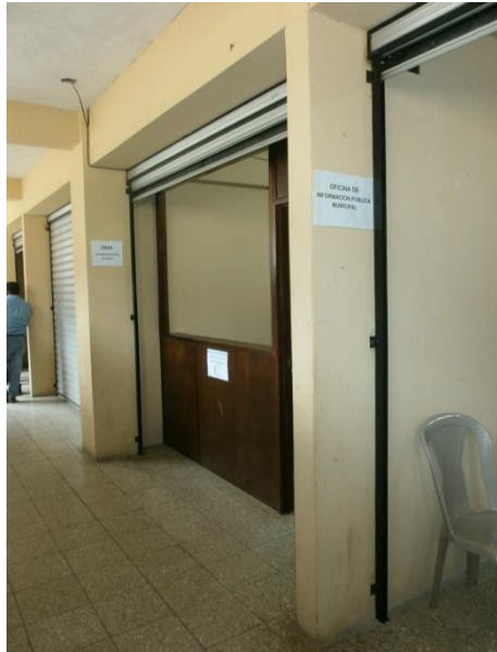
Ilustración 3, Oficinas ubicadas en Mercado Municipalidad de El Tumbador, San Marcos, Fuente Propia.
