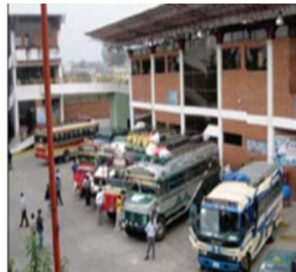
Se tiene una ventilación natural por medio del espaciamiento entre el techo y los cerramientos verticales.
