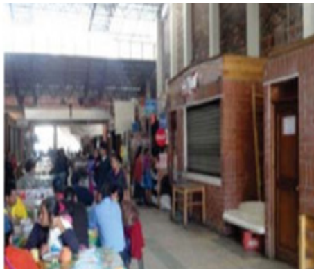
Para aprovechar luz natural indirecta tiene separaciones entre niveles del techo.
