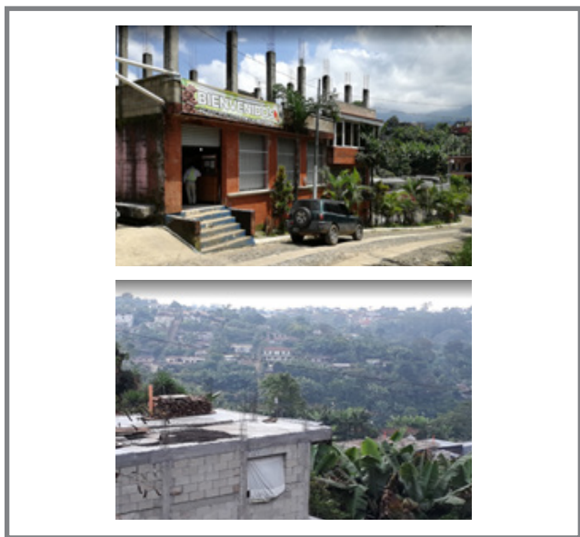
Figura 23: Servicios de vivienda, La Reforma San Marcos, Google Maps.
