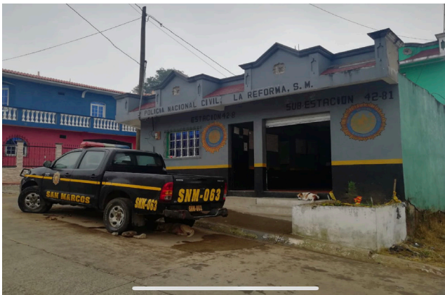
Sub estación PNC 42-81
