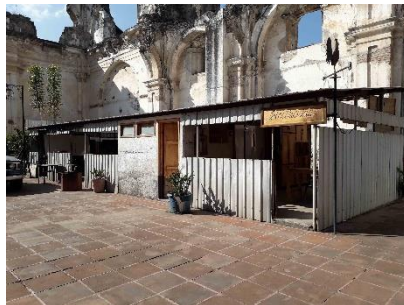
Imagen 6: Lámina galvanizada como material principal. Fuente: Propia, 2019.
