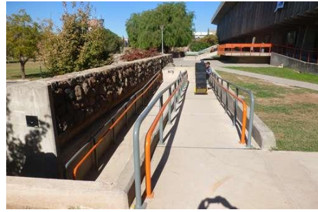
Imagen 27: Rampas de acceso personas con movilidad reducida.
