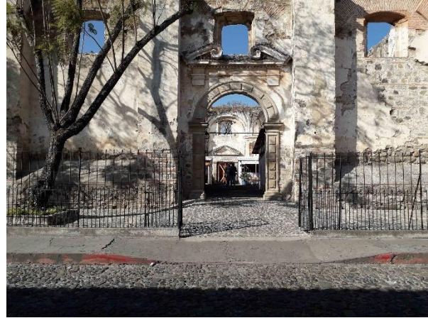
Imagen 5: Muestra el ingreso principal del proyecto sobre la 4ta. Calle poniente. Fuente: Propia, 2019
