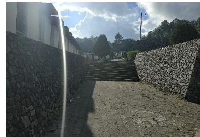
Imagen 6. Caminamientos exteriores ENRO. Juan José Díaz, Diciembre 2018
