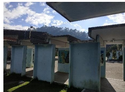
Imagen 12, Pasillos Techados ENRO. Juan José Díaz. Diciembre
