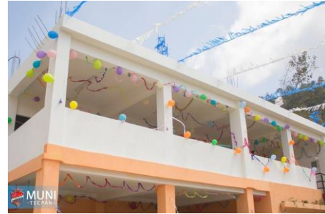
Imagen 52 Escuela de Chuatzite, recuperado de munitecpan.com.gt . (Mayo 2019)
