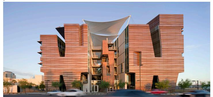
Fachada sobre 7th. street utilización de paneles para forrar estructura primaria del edificio a la vez conservando la temperatura interior .
