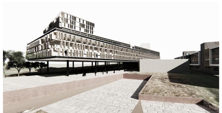
ENSAYO DE DOBLE FACHADA CON ELEMENTOS HORIZONTALES, POSIBLES CUBIERTAS AJARDINADAS
