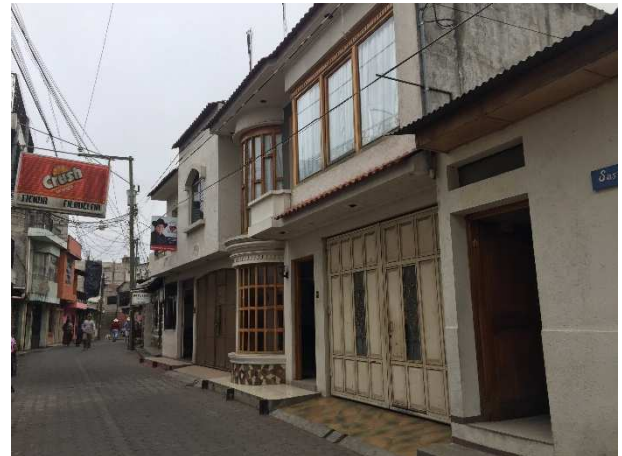
Ilustración 63: Viviendas Elaboración propia 2019
