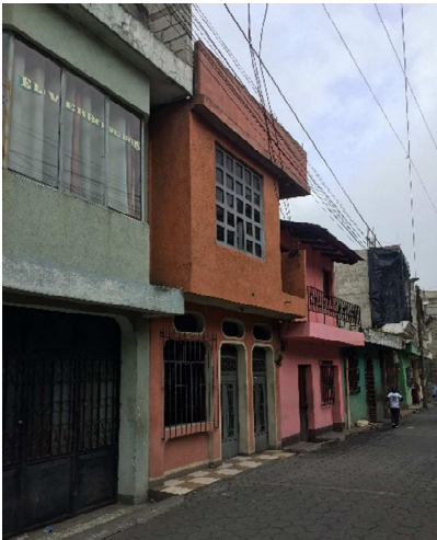
Ilustración 61: Viviendas Elaboración propia 2019
