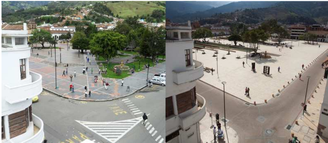
Ilustración 34: Antes y después de la intervención a la plaza
