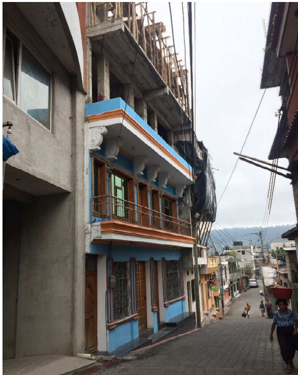
Ilustración 57: Vivienda de 4 niveles en construcción Elaboración propia 2019
