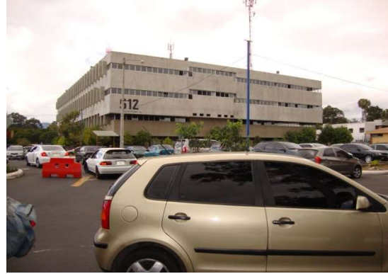
Fuente: M. V. Pérez Orellana. Edificio S-12 Frente al Terreno Asignado. Marzo 2013 45
