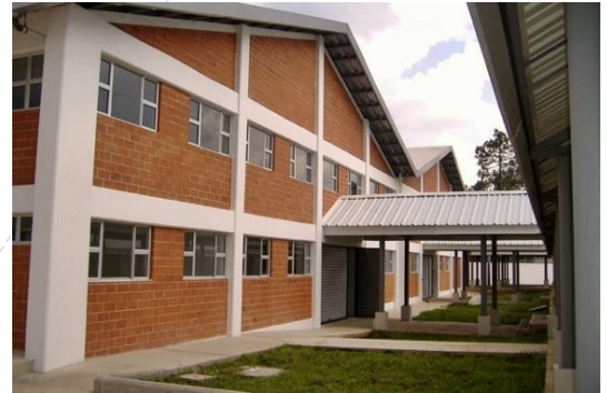
Imagen_023_18032018 Utilización del ladrillo como elemento de fachada y constructivo.
