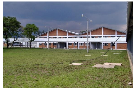
Imagen_017_18032018 Módulos con salida a espacios abiertos para la evacuación en caso de emergencia.
