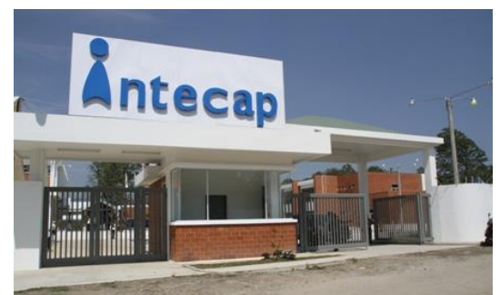
Imagen_022_18032018 Fachada de la garita de ingreso y su integración en forma al centro.
