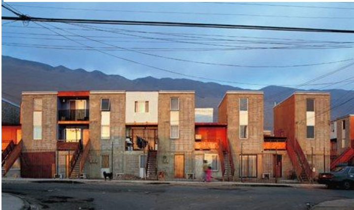
Ilustración 26, vista exterior 2 - Quinta Monroy
