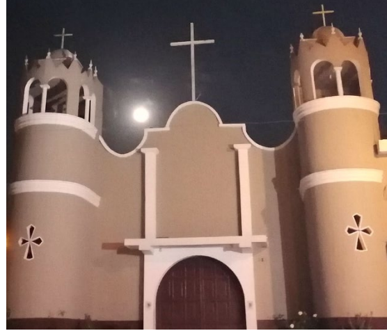
Figura 92: fachada principal de Parroquia “La Ascensión del Señor”, elaboración propia, agosto 2021
