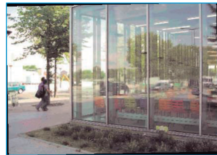
FOTO 167. Las ventanas transparentes garantizan un buen control de los espacios públicos.
