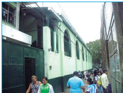
FOTO 53. CALLE 3er. ORDEN peatonal, ZONA 1
