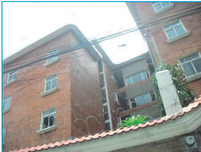
FOTO 92. EDIFICIO DE CONDOMINIO EN ZONA 2
