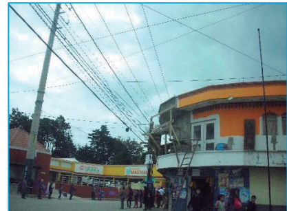
FOTO 112. NUDO EN INTERSECCION DE VIAS, EN ZONA 2
