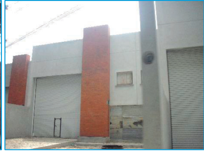
FOTO 106. OFICINAS Y BODEGAS EN CONSTRUCCION ZONA 1
