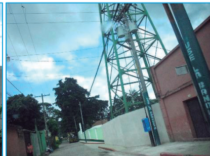
FOTO 15. TANQUE ELEVADO DE AGUA MUNICIPAL.
