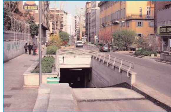
FOTO 178. Las rampas de este estacionamiento subterráneo están bien integradas con la acera grande
