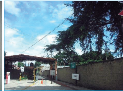
FOTO 97. ACCESOS CERRADOS A RESIDENCIAL EN ZONAS 1
