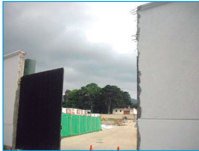
FOTO 95. VIVIENDAS EN CONSTRUCCIÓN EN SERIE EN ZONA 2
