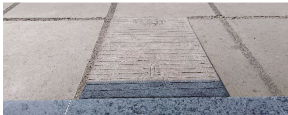
Imagen No. 23: Ingreso del Edificio B, rampa Fuente: Toma Propia, 2018.
