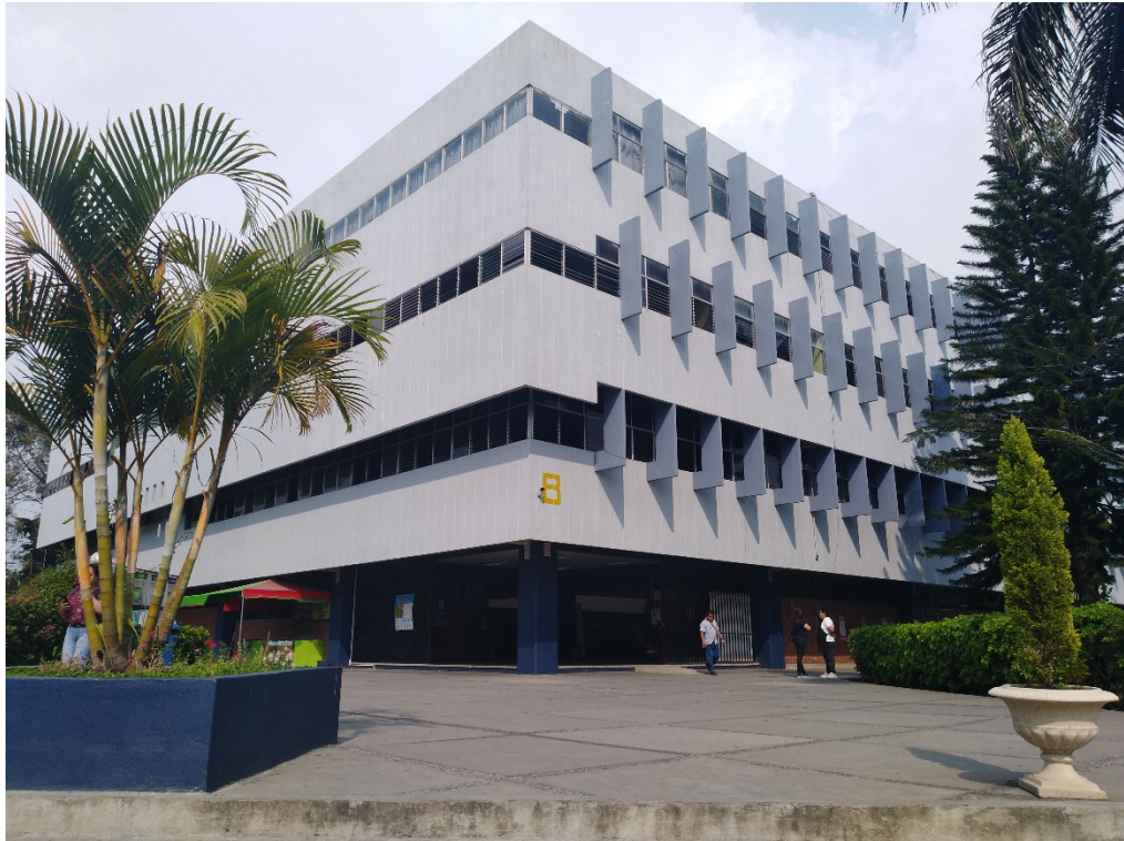
Imagen No. 22: Edificio B, Centro Universitario Metropolitano Fuente: Toma Propia, 2018.
