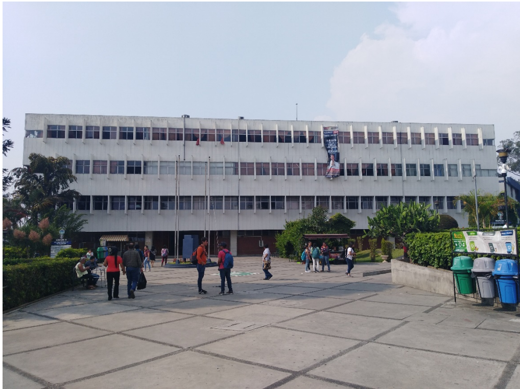
Imagen No. 21: Edificio A, Centro Universitario Metropolitano Fuente: Toma Propia, 2018.
