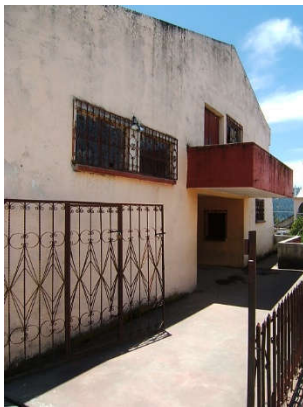
Fotografía 10 Salón Comunal Sibinal
