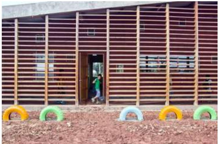
Imagen 43: Detalle de protección solar
