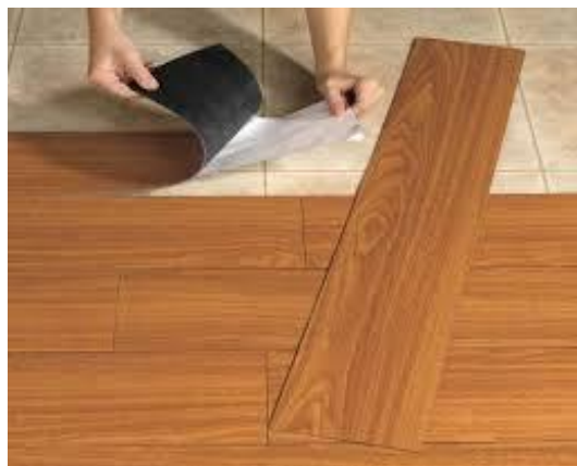
Imagen 54. Instalación de CPVC con sistema de click, un sistema que permite reutilizar el piso.
