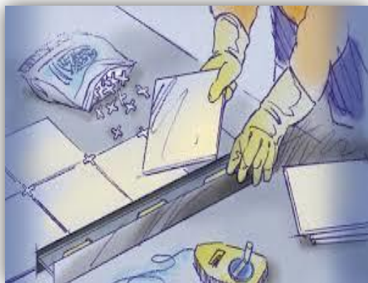
Imagen 93 y 94. Colocación de Piso, Colocación de Separados e Instalación sobre la Base
