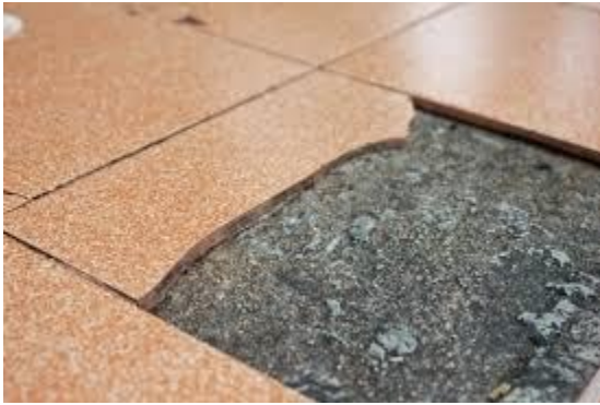
Imagen 102 y 103. Ejemplo típico de piezas quebradas por burbujas de aire dejadas por una mala aplicación del adhesivo o un adhesivo inadecuado.
