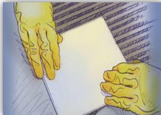
Imagen 93 y 94. Colocación de Piso, Colocación de Separados e Instalación sobre la Base
