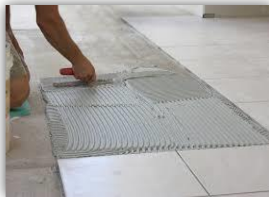
Imagen 95 y 96. Aplicación y Llanceado del Adhesivo sobre la base para pegar el piso Cerámico.
