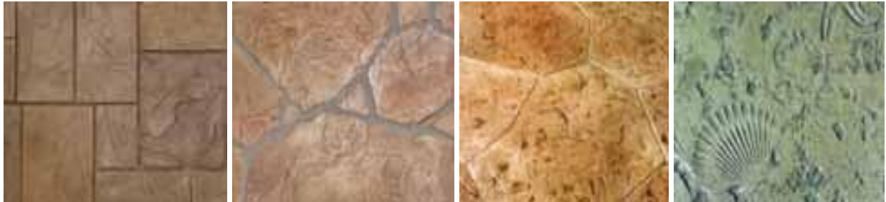
Imágenes 69 a 72. Acabado Estampado de Concreto y Ejemplos de Aplicaciones
