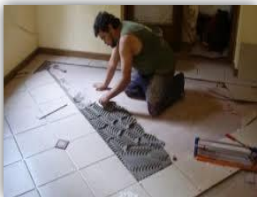
Imagen 95 y 96. Aplicación y Llanceado del Adhesivo sobre la base para pegar el piso Cerámico.
