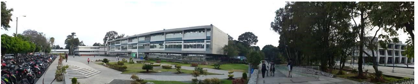
Fotografía 5. Edificio de la Dirección General de Administración -DIGA- (Izquierda). Al fondo lado derecho Edificio de Rectoría.
