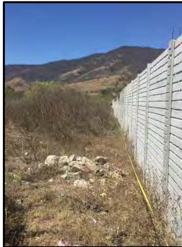
Figura No. 1.19 Muro perimetral prefabricado que sirve de limite entre el polígono y la calle que sirve de aproximación a este y a las bodegas municipales.
