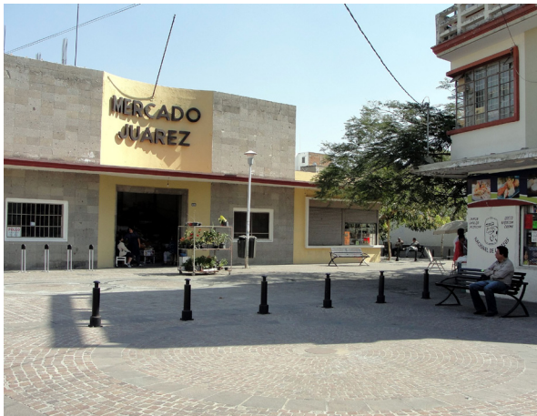
Figura 34: Recuperación de la Plazoleta Juárez, México. Fuente: https://revisionesgdl.files.wordpress.com/2013/05/dsc02312.jpg
