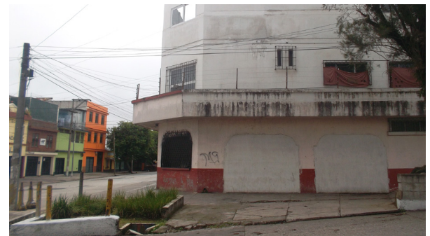
Figura 105: Construcción no original. Fuente: propia.
