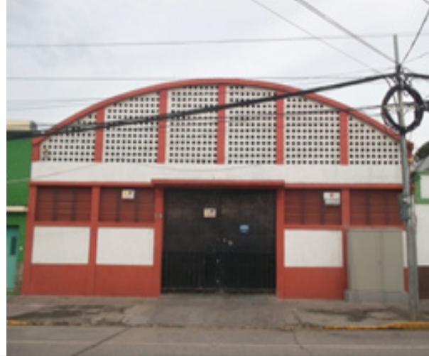
Figura 102: Edificio con cubierta curva.
