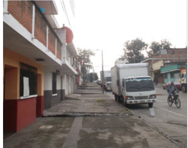
Figura 1 : Estado actual del Barrio Santa Marta. Fotografía Tomada en la 23 calle y avenida Elena zona 3. Fuente: Propia.
