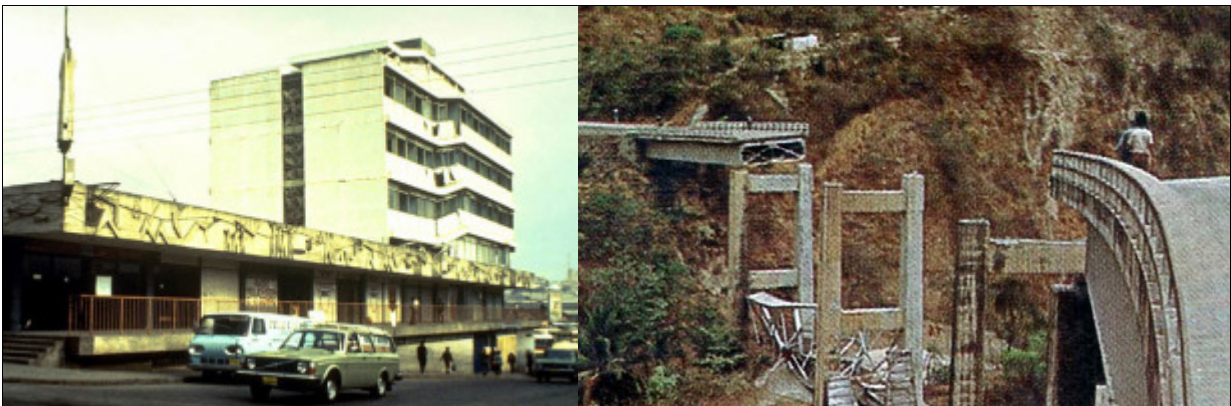
Figura 050: Daños causados por el terremoto del 4 de febrero de 1976. Colapso del Hotel Terminal (demolido posteriormente) y caída de losas en el Puente Corozal en la ruta al Atlántico Fuente: http://www.dequate.com/artman/publish/historia/moderna/terremoto-de-1976-544.shtml#.VG2oeXhDMw2015 , http://www.prensalibre.com/guatemala/comunitario/angustioso-amanecer-vivio-guatemala-hace-40-aos Consultada el 12/08/15.
