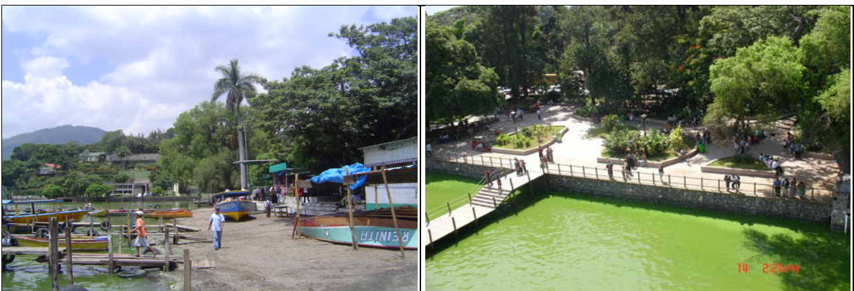
Figura 114: Playa Pública sin y con mejoras realizadas por AMSA; Fotografía: Rodolfo Godínez 2007.
