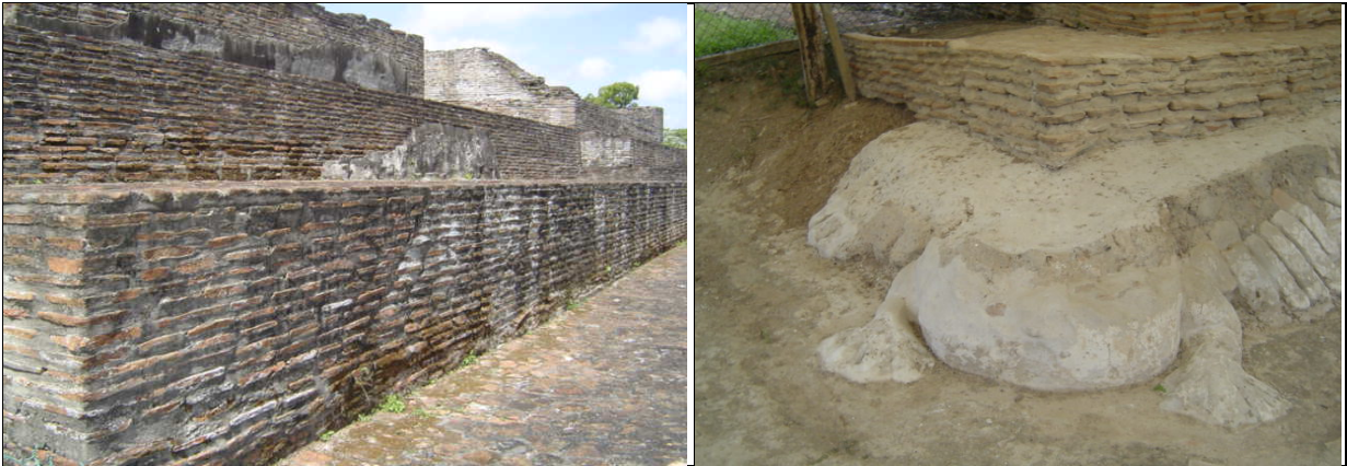
Figura 022: Arcilla cocida : Información tomada del museo de sitio en Comacalco, indica que el lugar tiene una superficie de 7.00 kms 2 ., en el estado de Tabasco, México desarrollado con tres sistemas constructivos entre los que destaca los basamentos erigidos con cuerpo de tierra compactada, revestida con acabado de cal de concha de ostión; los basamentos de tierra con ladrillo y las estructuras de mampostería de ladrillo; algunas partes con decoración de estuco. Tuvo una ocupación continua desde el período Clásico entre los años 250 a 900 d.C. en las fotografías se observa la base del templo I y la esquina del templo VII, Fotografías: Rodolfo Godínez (2006).
