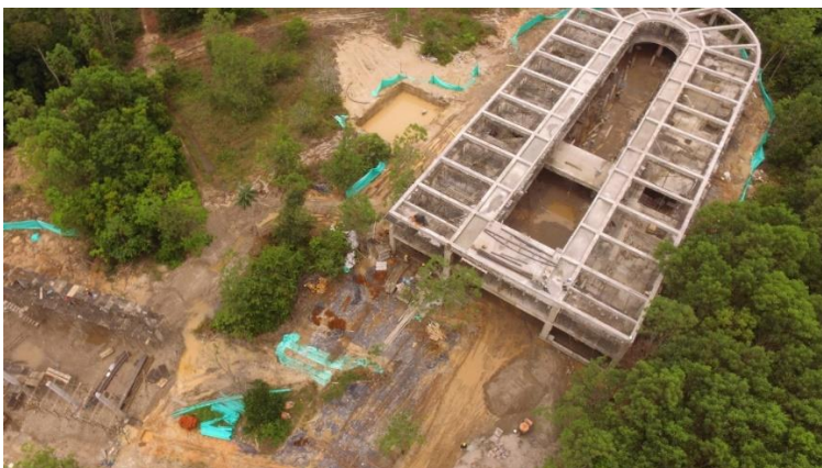
Imagen 8, Vista aérea del proceso de construcción IEAF
