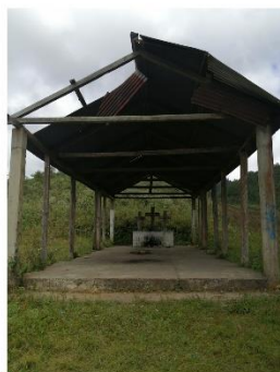
VISTAS DE MIRADOR LA CRUZ LOCALIZADA AL NORTE DEL MUNICIPIO
