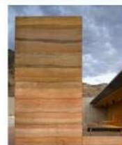
Utilizar materiales naturales como los muros de tierra apisonada, piedra y madera para un diseño sostenible y amigable con su entorno, ademas del uso de materiales locales.
