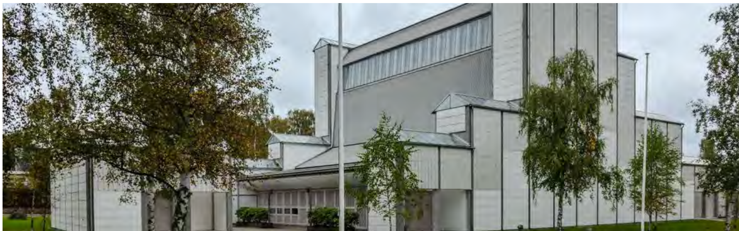
Figura 8. Exterior de la Iglesia de Bagsværd, fuente: https://www.urbipedia.org/hoja/Iglesia_de_Bagsv%C3%A6rd#/media/File:Utzon.IglesiaBagsvaerd.jpg
