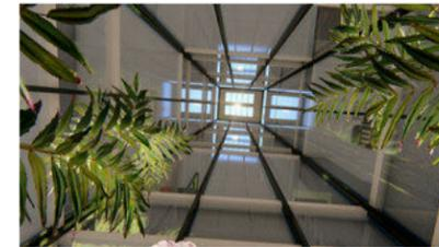
POZO DE LUZ PARA MEJOR ILUMINACIÓN Y VENTILACIÓN NATURAL, PERMITE QUE LA LUZ NATURAL PENETRE EN ESPACIOS Y DISMINUYE EL CONSUMO DE LUZ ELÉCTRICA.
