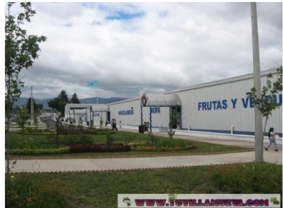
FOTO # 7 EXTERIOR MERCADO DE VILLA NUEVA, GUATEMALA
