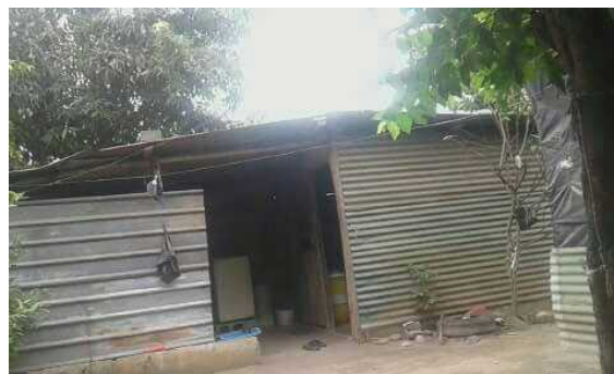
Fuente: Captura Propia, "vivienda con muros y techo de lámina y piso de tierra"
