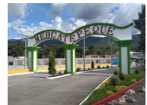
Ingreso a mercado y terminal de buses
