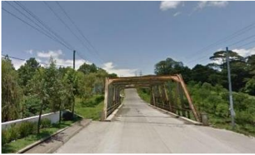
Vista del puente sobre el río Chío
