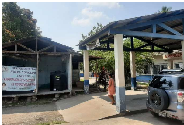
Figura 6. Ingreso principal y de emergencias del CAP, Nueva Concepción, Escuintla
