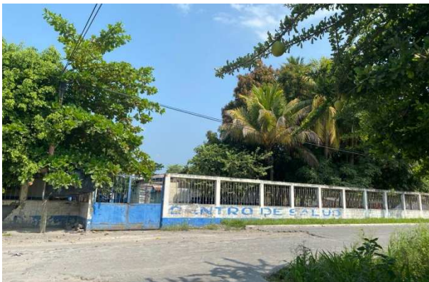
Figura 5. Muro perimetral del CAP, Nueva Concepción, Escuintla
