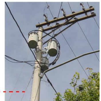
Poste de alumbrado público con transformadores.
