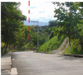
Infraestructura vial que conecta carretera a Villa Canales y los condominios en la parte oeste.
