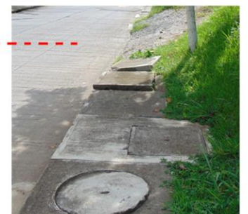
Drenaje de aguas pluviales fuera del sitio, en parte baja.
