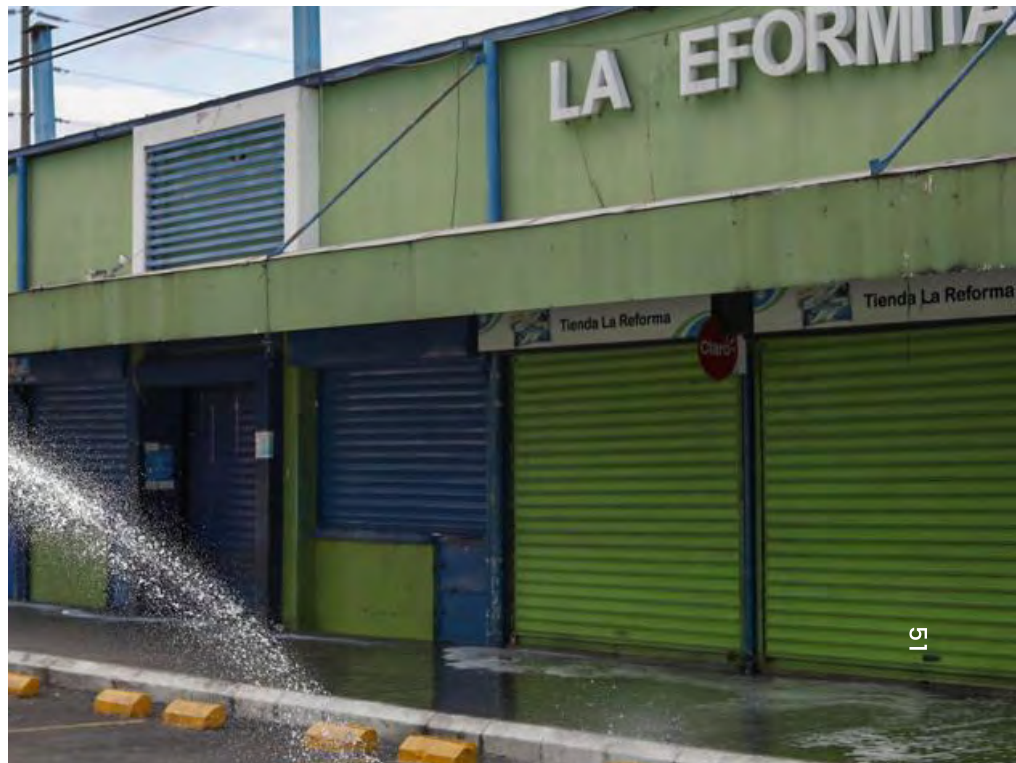
Fig. 10 Locales comerciales exteriores
