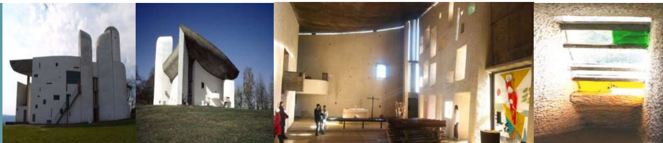
Figura 5. Fachada de la Iglesia de Notre Dame Du Haut Fuente: https://www.plataformaarquitectura.cl/cl/02-74548/clasicos-de-la-arquitectura-ronchamp-le-corbusier
