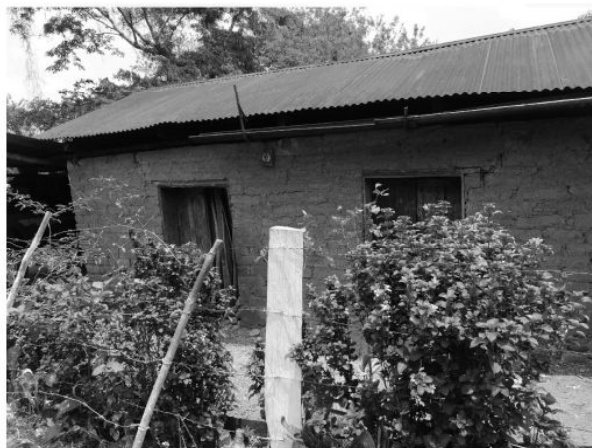
Figura 94. Vivienda de adobe del Municipio
