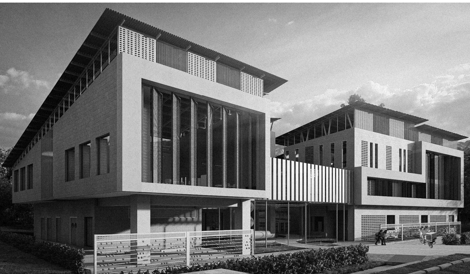
CENTRO COMUNITARIO MUNICIPAL SANTA MARÍA IXHUATÁN, SANTA ROSA, GUATEMALA
