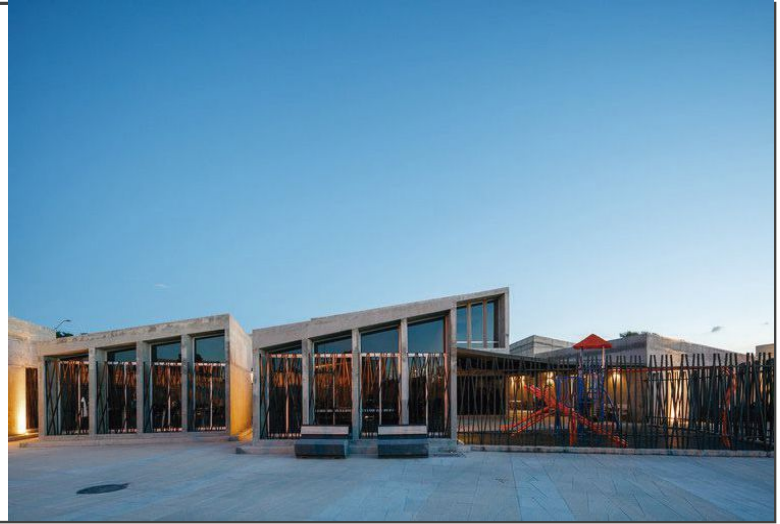
Figura 43 . Fachada frontal Centro comunitario en Celaya
