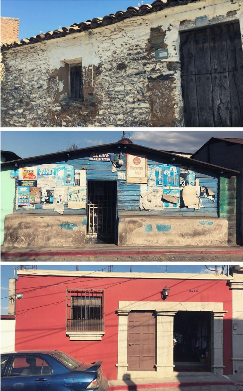
Fotografía 26. Tipologías constructivas de Magdalena Milpas Altas. La primera de arriba abajo es una vivienda de adobe, de las últimas que quedan en el municipio. La segunda es una vivienda de madera y cubierta de lámina. La tercera es una vivienda de mampostería confinada, una de las más modernas del lugar. Fuente: Elaboración propia.
