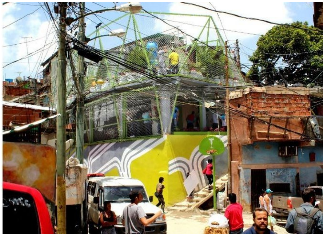
Fotografía 14. Intervención en Petare, Venezuela. Arriba se puede observar el estado inicial del edificio. Abajo se observa el lugar luego de la intervención. Fuente: https://www.plataformaarquitectura.cl/cl/755609/como-el-proyecto-espacios-de-paz-esta-transformando-los-espacios-comunitarios-en-venezuela
