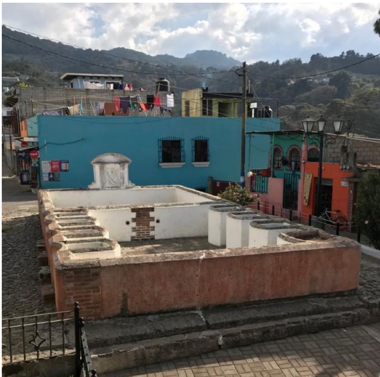
Fotografía 37. Estado actual de la pileta histórica. Fuente: Elaboración propia.
