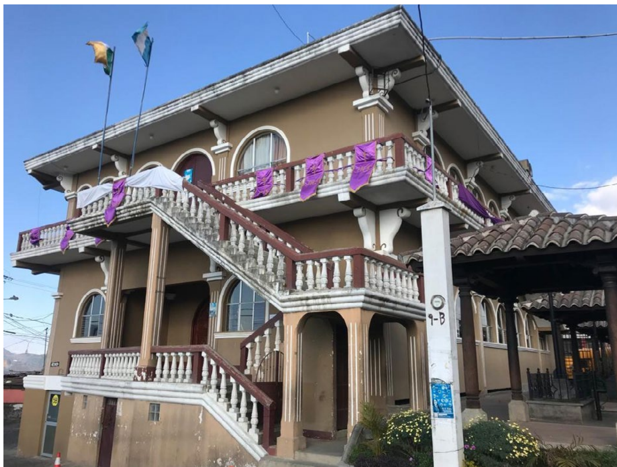
Fotografía 33. Municipalidad de Magdalena Milpas Altas, fachada principal. Fuente: Elaboración propia.
