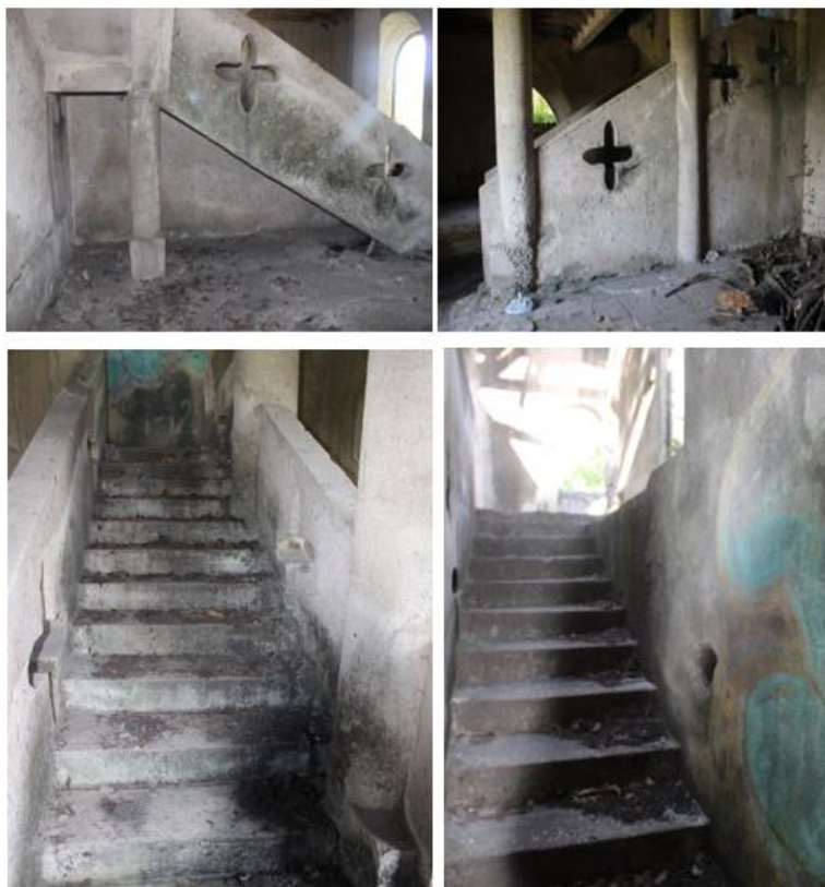
Figuras 90-91-92-93. Vista de las gradas de piedra labrada localizada dentro del edificio. Fuente: Velásquez Luna, 2018
