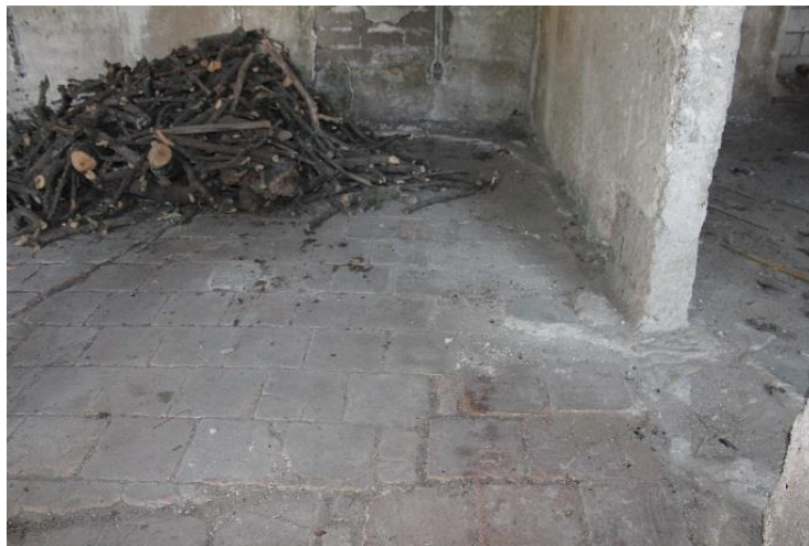
Figura 87. Se puede observar el piso de losa de barro cocido, adherido con una capa de cal y arena. Fuente: Velásquez Luna, 2016.
