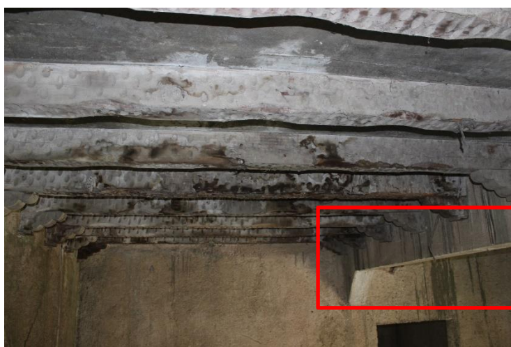
Figura 108. Entrepiso de cemento, el cuadrado en rojo muestra las vigas de concreto armado que están amarradas a columnas de concreto incrustadas sobre muros (tabiques) de block. En la fotografía es posible observar el artesanado de madera de pino, tallada y afectada posiblemente por la fundición del entrepiso de cemento. Fuente: Velásquez Luna, 2018.
