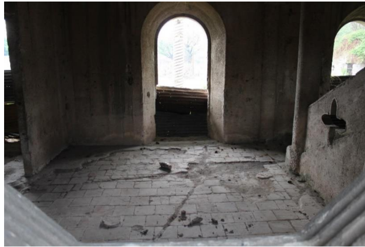
Figura 86. Vista del piso cortado, el superior corresponde a una mezcla de cemento líquido de 0.10 m de grosor y el inferior a losas de barro cocido el cual posiblemente corresponda al piso original de la construcción. Fuente. Velásquez Luna, 2016.
