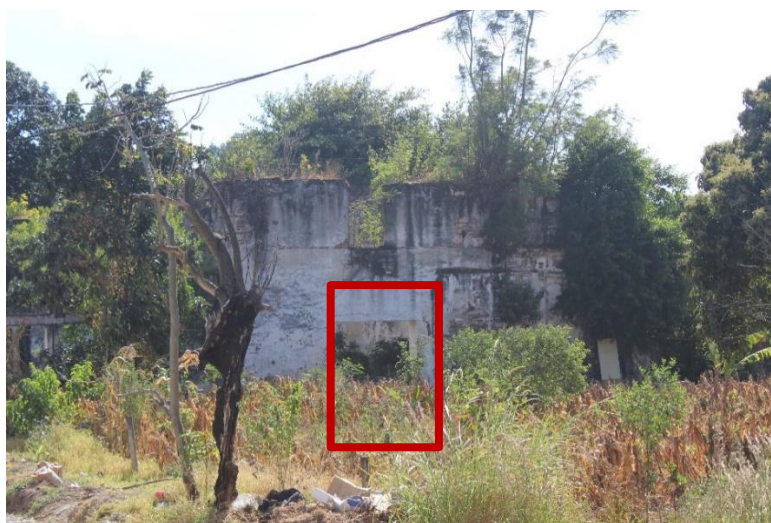
Figura 34. Vista de la fachada del oratorio en donde se puede observar el vano de la puerta de ingreso principal. Fuente: Velásquez Luna, 2016.
