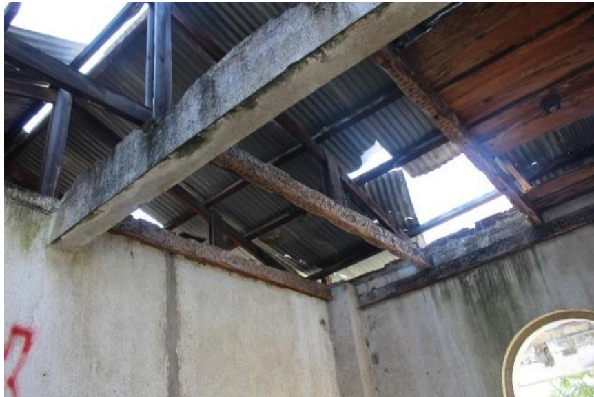
Figura 79. Detalle del artesonado de madera, columnas y vigas de concreto incrustadas y las láminas de zinc. Fuente: Velásquez Luna, 2018.
