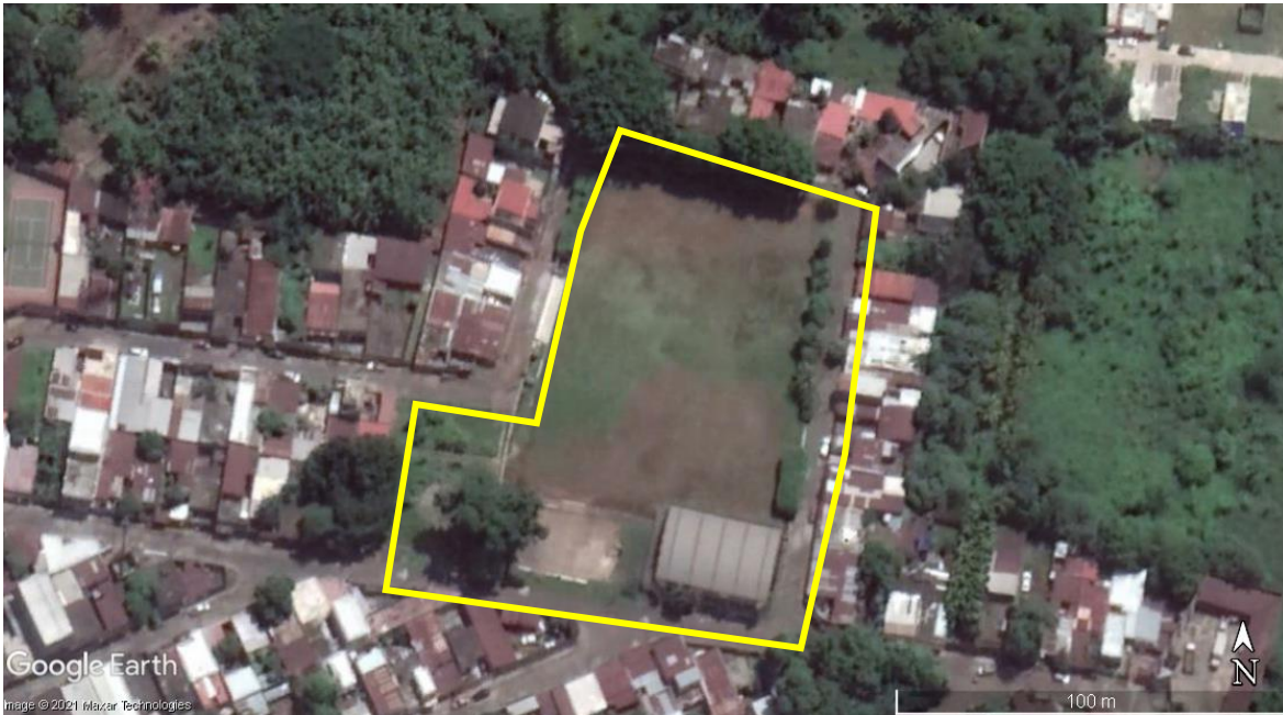
Figura 51. Ortofoto predio municipal designado para el proyecto, Google Maps, 2021.
