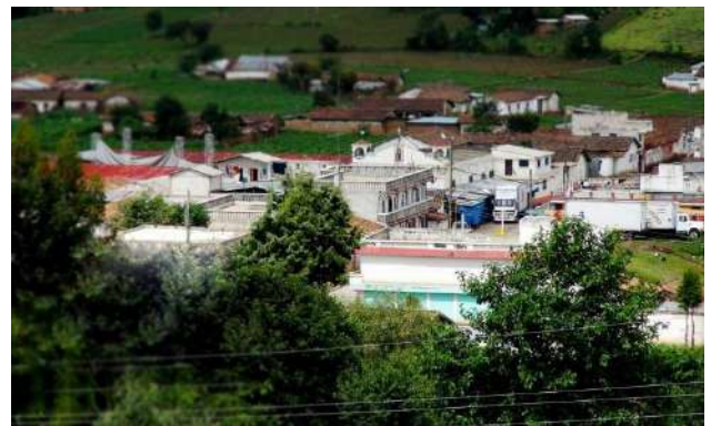
Figura 81. Contraste en el paisaje construido; primer plano con nuevos sistemas constructivos, y segundo plano ejemplifica la vivienda antigua de San Cristóbal Totonicapán, fotografía por Ovop, https://ovopguatemala.org/productos-grupos/san-cristobal-totonicapan/
