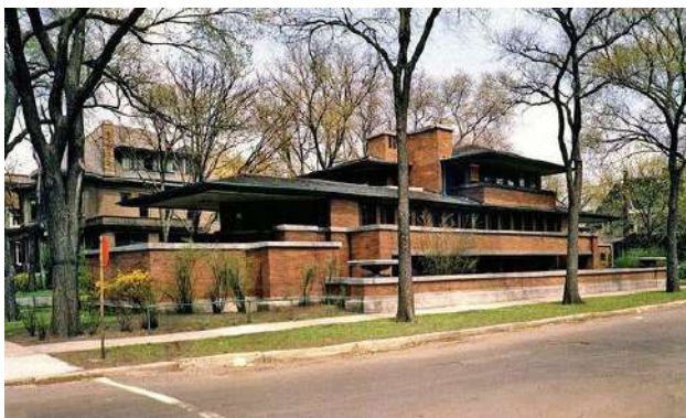
Figura 13. Casa Robbie, diseño de Wright. La forma integrada a su emplazamiento, ejemplificada como la horizontalidad del solar es a la horizontalidad de sus elementos. Fotografía publicada por StudyBlue, https://www.pinterest.es/pin/350436414725124711/
