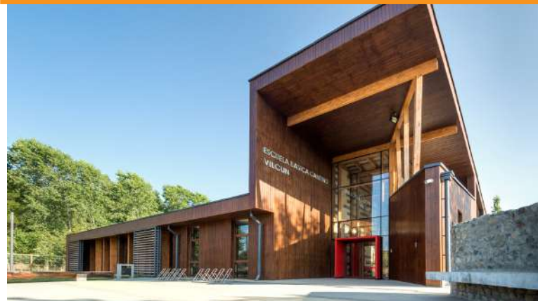
Figura 44. Ingreso principal de la escuela rural y centro social, fotografía publicada por Plataforma Arquitectura, https://www.plataformaarquitectura.cl/cl/933525/escuela-rural-basica-cantino-taller-viga-maestra?ad_source=search&ad_medium=search_result_all
