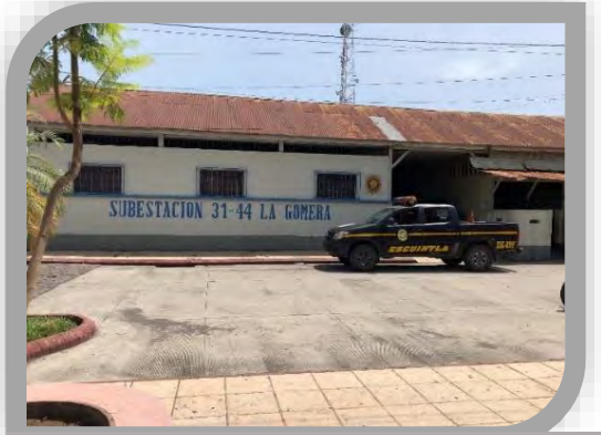
Figura No. 39 Subestación 31-44, La Gomera. Fuente: Propia. Tomada en 2018.
