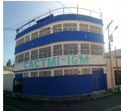
Figura 18. Vista frontal Elaboración propia.
