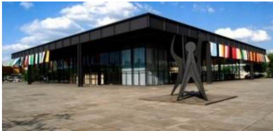
Figura 5, Vista Exterior Nueva Galería Nacional de Berlín
