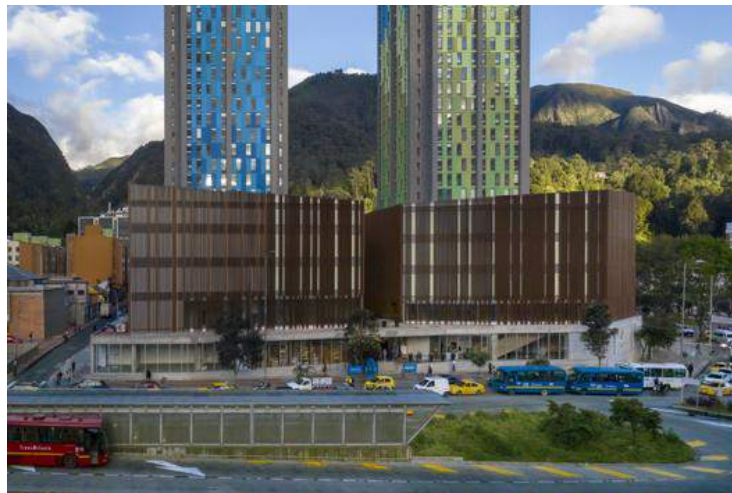
Figura 53 Centro Cultural de artes audiovisuales Bogotá. Recuperado de: https://www.plataformaarquitectura.cl/cl/920633/centro-cultural-de-las-artes-audiovisuales-nueva-cinemateca-de-bogota-colectivo-720/5d23a695284dd1cae5000048-centro-cultural-de-las-artes-audio
