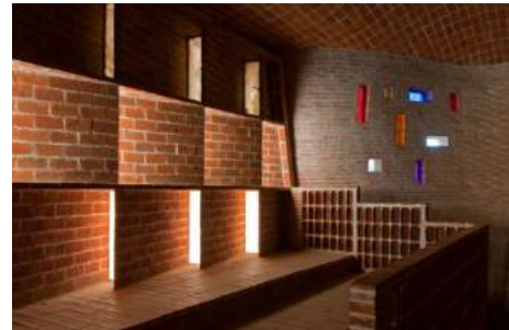
Figura 5 Iglesia de Atlántida, Eladio Dieste, utiliza ladrillos cerámica ya que era producido localmente en grandes cantidades y a bajo costo. Recuperado de: https://sobrearquitecturas.wordpress.com/2016/03/29/iglesia-de-atlantida-eladio-dieste/
