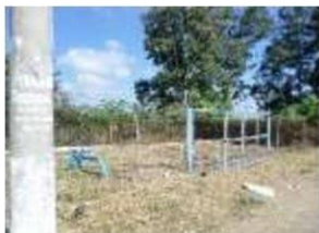
Foto No 3 INGRESO PARA MANTENIMIENTO sobre la 16 Avenida
