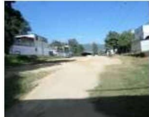
FOTO No 1 INGRESO PRINCIPAL sobre la 18 calle
