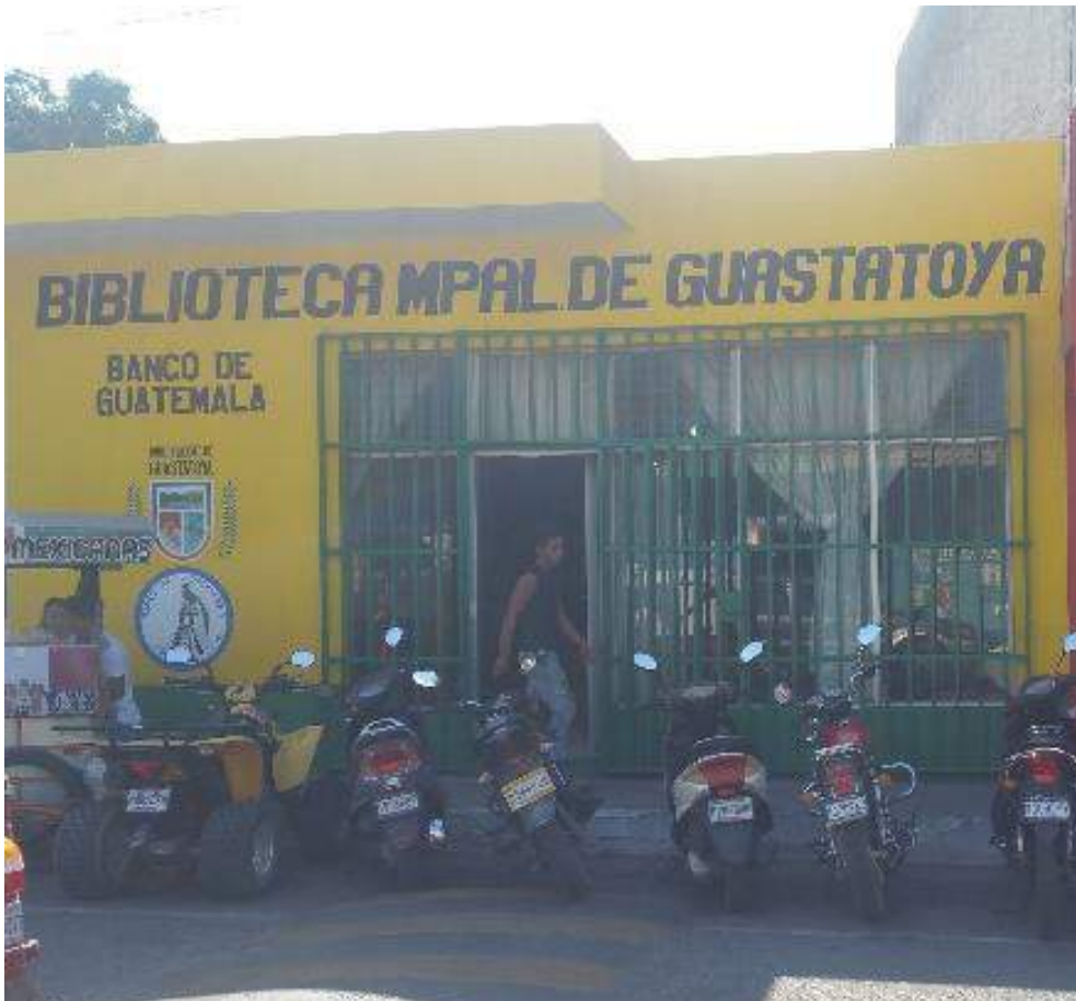
Fotografía I: Fachada del inmueble
