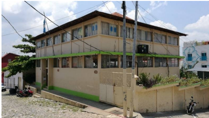
FOTOGRAFÍA 4: Edificio Municipal que se inauguró en 1985. Terreno de 15.40x12.34 - 190.036m 2 FUENTE: Propia, 2019.
