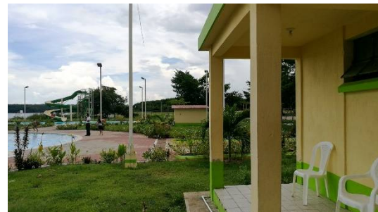
FOTOGRAFÍA 30: Módulo de Vestidores y duchas. Dan servicio a los usuarios que utilicen las piscinas. FUENTE: Propia, 2019.
