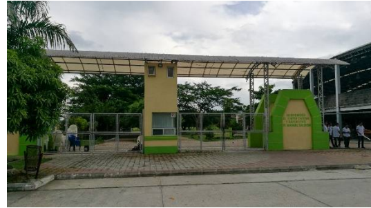
FOTOGRAFÍA 24: Garita de ingreso peatonal, Centro cultural. Módulo de identificación de visitantes, previo a ingreso. FUENTE: Propia, 2019.
