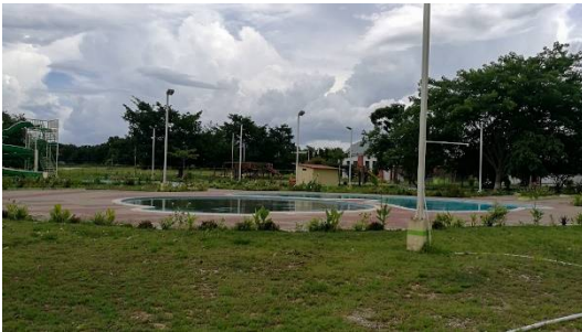
FOTOGRAFÍA 29: Piscinas de uso recreativo en Centro Cultural y Deportivo Manuel Baldizón. Las tres piscinas se encuentran ubicadas a un costado del sitio para el Edificio Municipal. Una piscina infantil circular de 10m de diámetro, junto a esa una piscina circular de 15m de diámetro, y otra piscina rectangular de 13 x 20m que cuenta con un tobogán. FUENTE: Propia, 2019.
