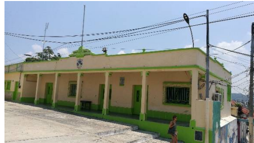
FOTOGRAFÍA 1: Actuales Oficinas de IUSI, Monitoreo y Turismo. FUENTE: Propia, 2019.
