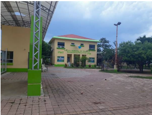
FOTOGRAFÍA 25: Módulo de Policía Municipal -PM- y Policía Municipal de Tránsito -PMT-. Al descentralizar el Edificio Municipal, las unidades de PM y PMT, se ubicaron dentro del Centro Cultural y Deportivo Manuel Baldizón. FUENTE: Propia, 2019.
