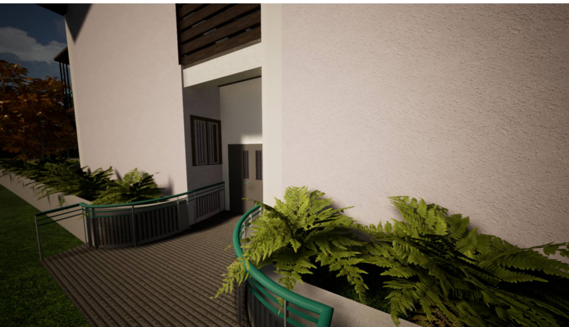
IMAGEN 37: Salida de emergencia, Edificio Municipal. FUENTE: Elaboración Propia, 2020.
