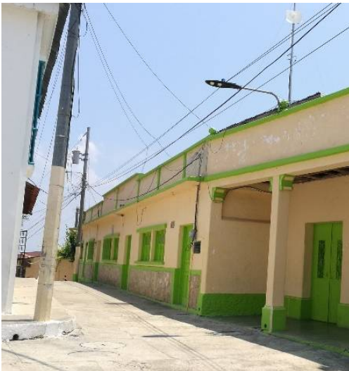
FOTOGRAFÍA 2: Actuales Oficinas de Servicios Públicos y DMP. FUENTE: Propia, 2019.
