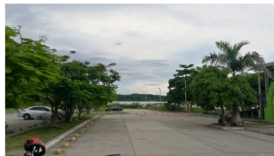
FOTOGRAFÍA 22: Distribución de islas de estacionamiento. Se tiene capacidad de 32 automóviles por isla de estacionamiento, se tiene una parte que se utiliza para estacionar motocicletas. La capacidad total estimada del estacionamiento es de 175 automóviles. FUENTE: Propia, 2019.
