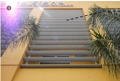
En la fachada se hace uso de parteluces para la protección solar, además de estar separadas de la ventana para que fluya el aire.
