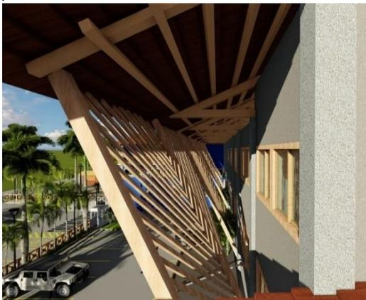
Detalle de parteluces norte, se aprecia la separación e inclinación para dejar fluir aire al interior.
