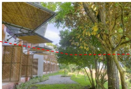
Diseño de parteluces con materiales como acero y madera.
