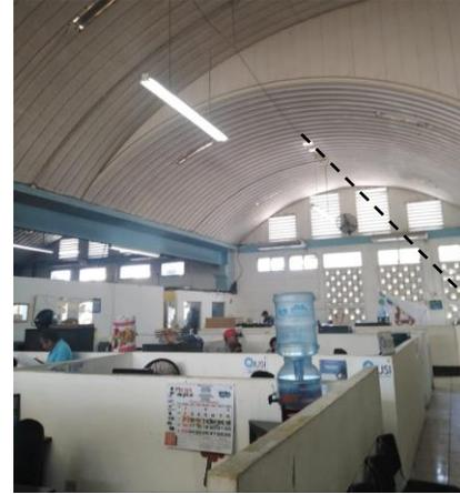
El techo de la municipalidad es una cubierta que cubre todo el salón donde están ubicada, a pesar de la altura de esta aproximadamente de 10 mts. Se genera mucho calor dentro ya que no tiene una ventilación adecuada para los usuarios, todos tienen ventiladores en su cubículo para que puedan crear condiciones adecuadas para trabajar. Las ventanas se pueden apreciar al fondo, pero no entra suficiente ventilación para el interior.
