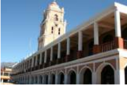
Figura 117. Edificio de Gobernación Departamental de Huehuetenango. (Fotografía por Marco Antonio Escalante Herrera, 2015).
