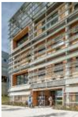
Figura 65. Vista exterior - Piel bioclimática - Centro de Investigación ICTA-ICP · UAB. Fotografía de Adriá Goula (Plataforma Arquitectura, 2015)
