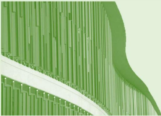
Se utilizarán lamas, pantallas, celosías o parteluces como elementos exteriores para proteger los espacios interiores de la radiación solar y permitir el paso del aire y luz difusa.
