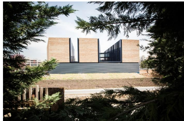
Figura 5: Ayuntamiento de Byblos, Líbano https://www.plataformaarquitectura.cl/cl/788360/ayuntamiento-de-byblos-hashim-sarkis/572bd75ae58ece43e0000017-byblos-town-hall-hashim-sarkis-photo
