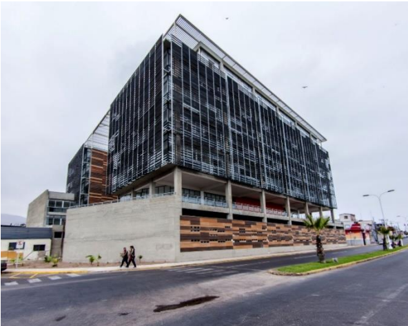
Figura 12: Vista noroeste municipalidad de Iquique. http://www.arquitecturaenacero.org/proyectos/edificios-de-equipamiento-y-servicios/edificio-consistorial-de-la-municipalidad-de-iquique
